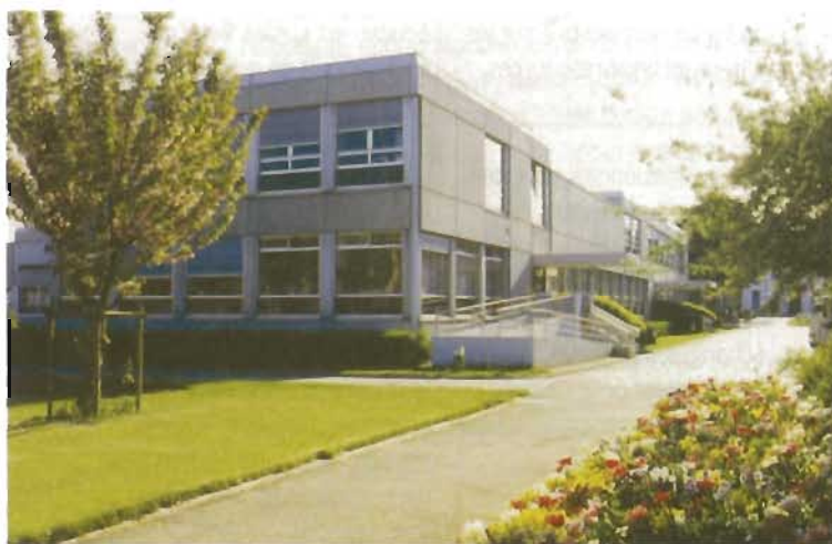
Le Centre hospitalier Saint-Jean-de-Dieu, bâtiment administratif à Lyon (69).
